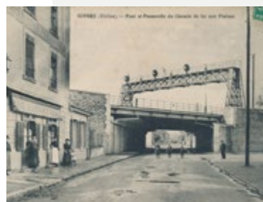
Vue du pont et passerelle du chemin de fer aux Plaines - date inconnue Source : Archives municipales de Givors.
