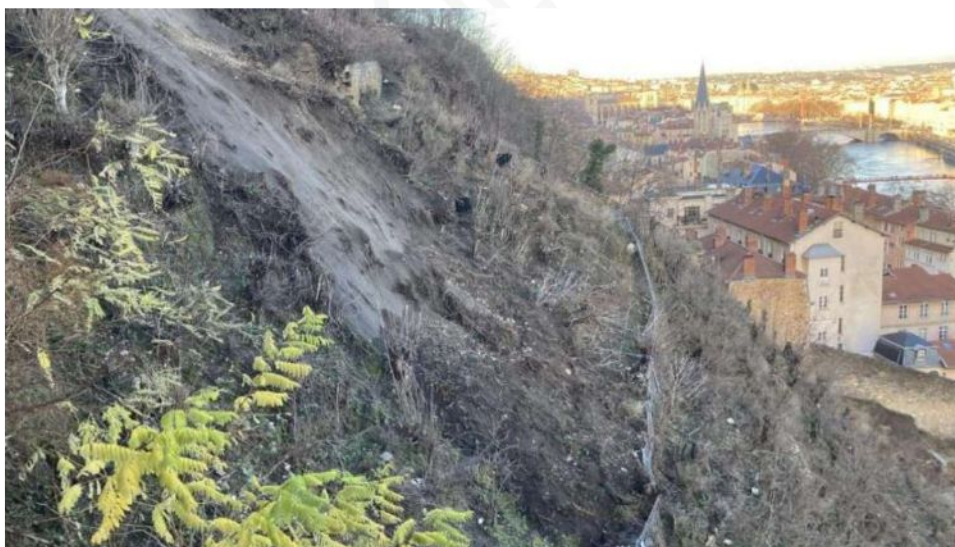
Figure 6 : Glissement de terrain surplombant la rue de la Quarantaine à Lyon, 2021
