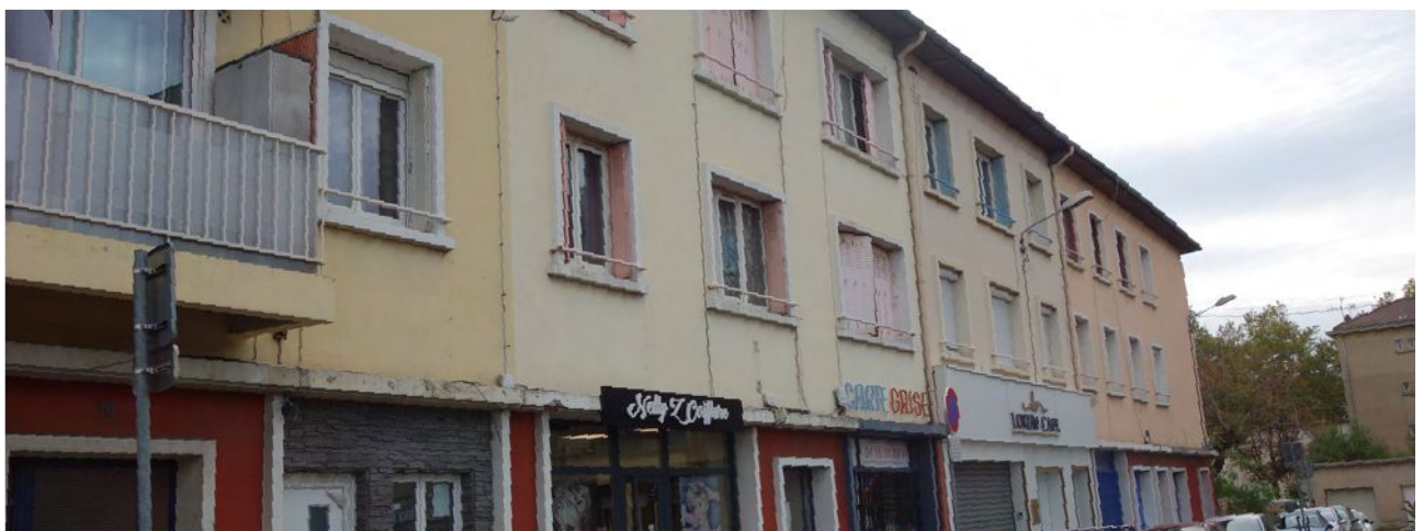
allées 5 à 10 place du colonel Fabien (source CAUE)
