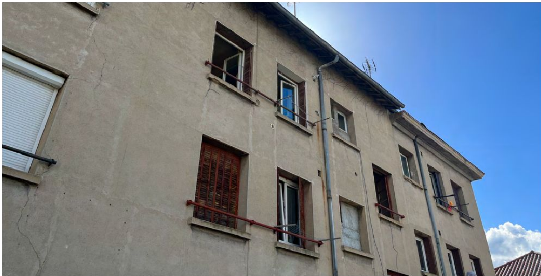
façade arrière du 5 rue Victor Hugo (source CAUE)
