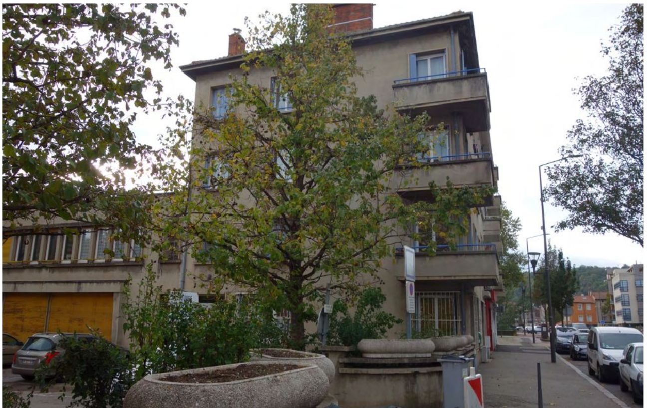
vue sur la façade nord du n°6 rue Victor Hugo (source : photo personnelle)
