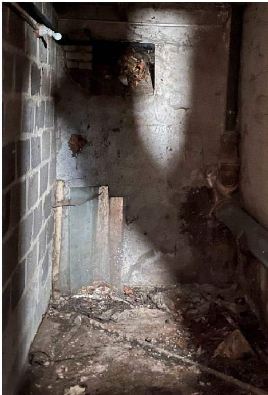
sous-sol du 2 rue Victor Hugo (source CAUE)
