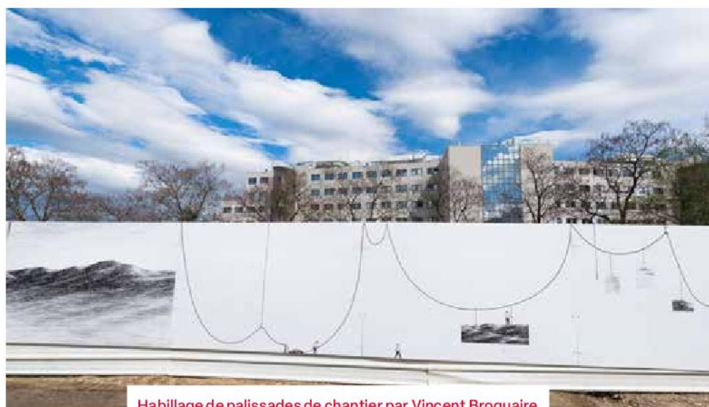
Habillage de palissades de chantier par Vincent Broquaire
