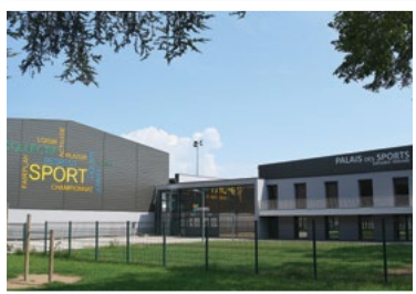
Rénovation du Palais des sports
