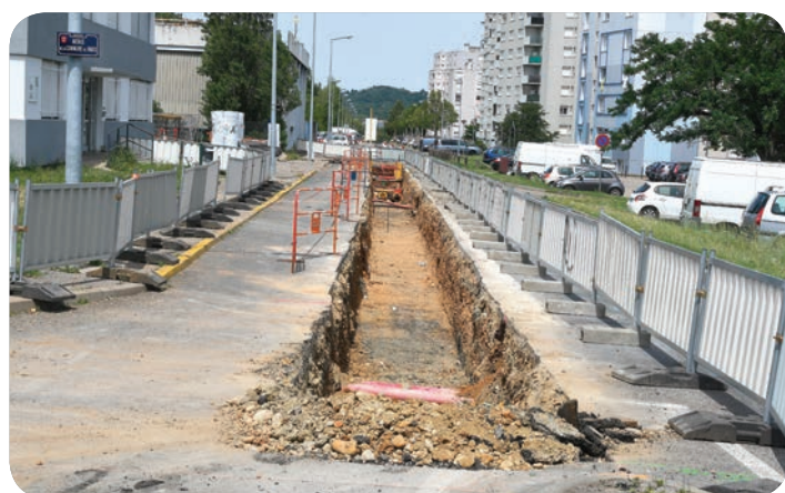
La chaufferie de Givors, sous gestion métropolitaine, a intégré le bois comme énergie renouvelable modifiant ainsi le mix énergétique du réseau chaleur de la ville.
