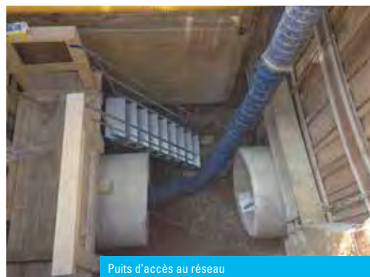
Puits d'accès au réseau
